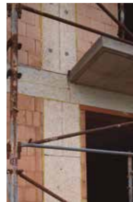
Eliminación de puentes térmicos.
